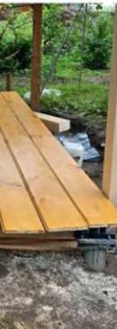
Доски обшивки сначала прибили, потом обрезали электролобзиком.
