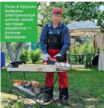
Пазы в брусках выбраны электрической цепной пилой, чистовая обработка — ручным фрезером.
