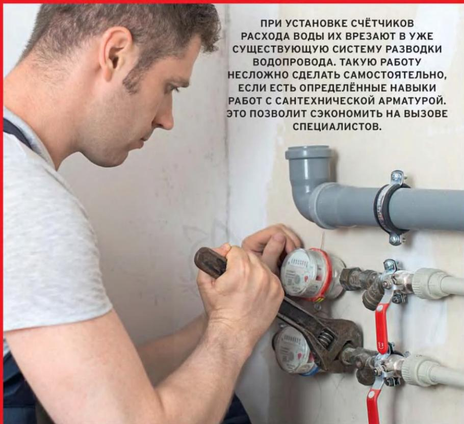
ПРИ УСТАНОВКЕ СЧЁТЧИКОВ РАСХОДА ВОДЫ ИХ ВРЕЗАЮТ В УЖЕ СУЩЕСТВУЮЩУЮ СИСТЕМУ РАЗВОДКИ ВОДОПРОВОДА. ТАКУЮ РАБОТУ НЕ СЛОЖНО СДЕЛАТЬ САМОСТОЯТЕЛЬНО, ЕСЛИ ЕСТЬ ОПРЕДЕЛЁННЫЕ НАВЫКИ РАБОТ С САНТЕХНИЧЕСКОЙ АРМАТУРОЙ. ЭТО ПОЗВОЛИТ СЭКОНОМИТЬ НА ВЫЗОВЕ СПЕЦИАЛИСТОВ.
