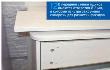
**12** В передней стенке ящиков имеются отверстия  $\varnothing$  3 мм, в которые изнутри закручены саморезы для разметки фасадов.
