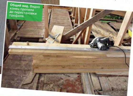
Профиль, не касаясь нитки, устанавливаем вдоль на одинаковом минимальном расстоянии и крепим саморезами. Чтобы профиль не сдвинулся в момент крепления, надо его крепко прижать. Сделаем первый проход пилой, переставляем профиль дальше. В идеале под другой край пилы надо положить для упора другую доску такой же толщины. Если такой опоры нет, придётся следить за горизонтальным положением пилы, но это проще, чем пилить по прямой без направляющей.
