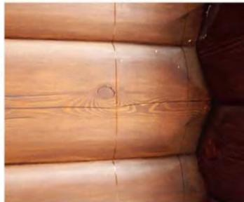
Этот красивый деревянный дом из лиственничного лафета имел серьёзный недостаток — негерметичные угловые соединения. Зимой в доме будет холодно. Также были плохо выполнены примыкания пароизоляции кровли к стенам, и по стенам стекал конденсат. Дом был куплен со скидкой на ремонт, и новые жильцы остались довольны.
